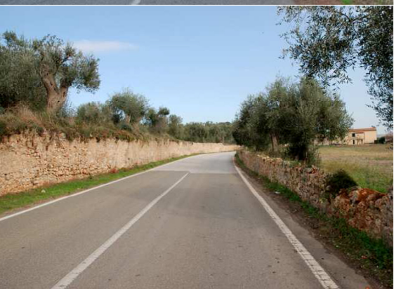
Muri a secco di contenimento degli oliveti (Orbetello)
